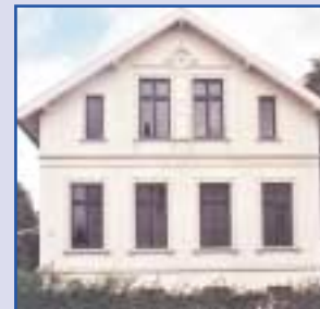
Eine Oldenburger „Hundehütte“ nach der energetischen Sanierung
